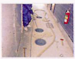
外部、屋外排水マスからの排水管高圧洗浄をしっかりと行います。
