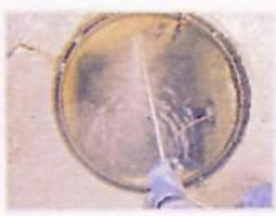
外部、屋外排水マスからの排水管高圧洗浄をしっかりと行います。
