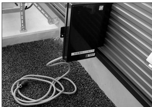
写真4 屋外。常設された線に発電機を繋ぐだけでOK
