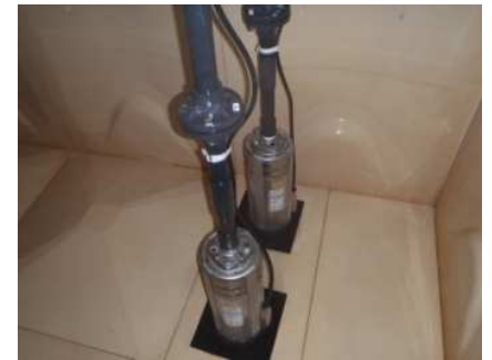
給水ポンプ設置作業
