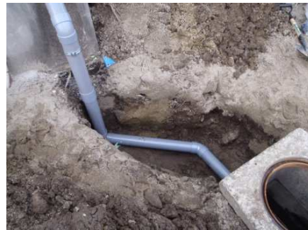
汚水管設置作業
