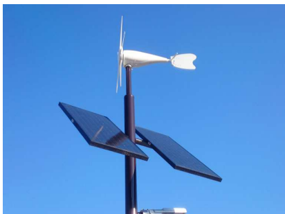
本社設置 ハイブリッド照明
