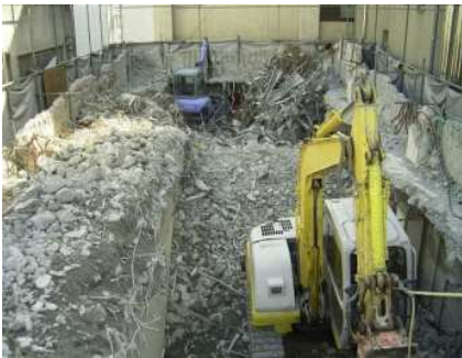
建築物解体工事
