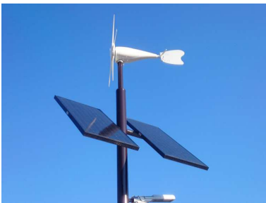
本社設置 ハイブリッド照明
